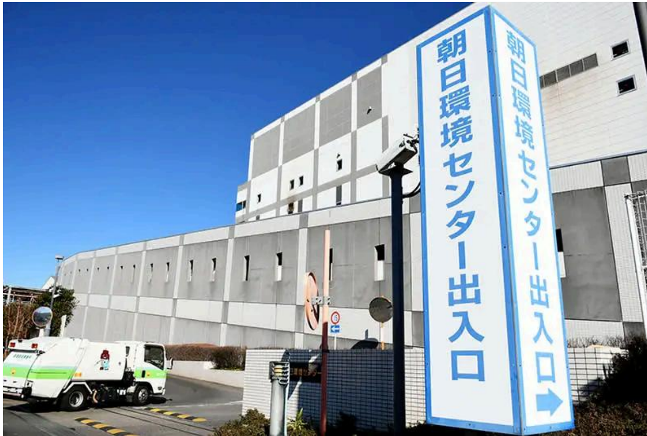
ごみピットで火災が発生し、一般ごみの受け入れと処理を停止している朝日環境センター
